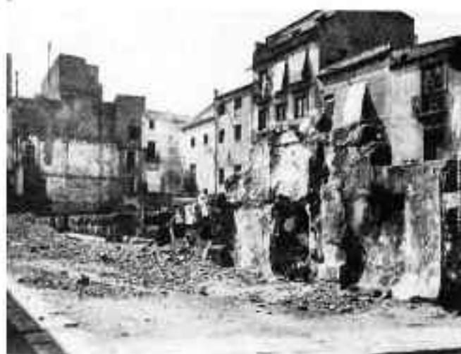
Propuesta de tratamiento del muro de la Plaza del Forum según J. Martorell (1920) y fotografía del muro descubierto en 1919 (anteriormente calles de Santa Teresa y Mercería).
