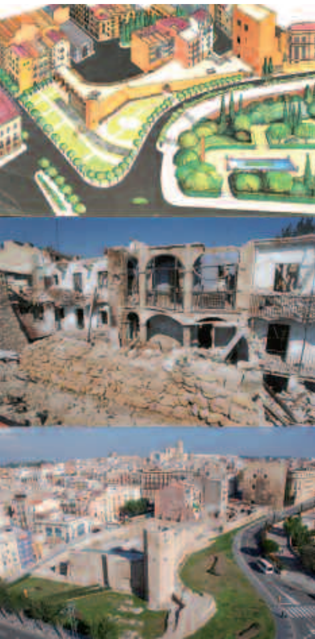
Propuesta de recuperación de la cabecera del Circo, según X. Dupré i J. Sempere (1991), derribo de las viviendas sobre la cabecera oriental del Circo (1991) y vista actual (2009).
