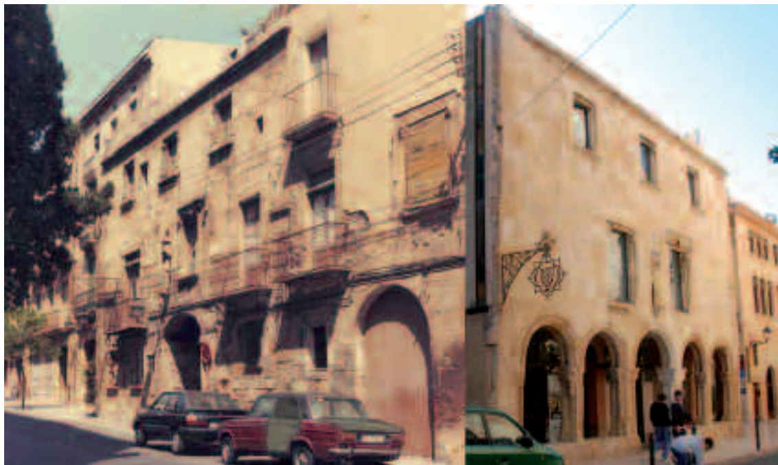
Antiguo hospital de Santa Tecla antes de su rehabilitación (BHPT) y tras los trabajos de restauración (X. Tolosana-MHT).
