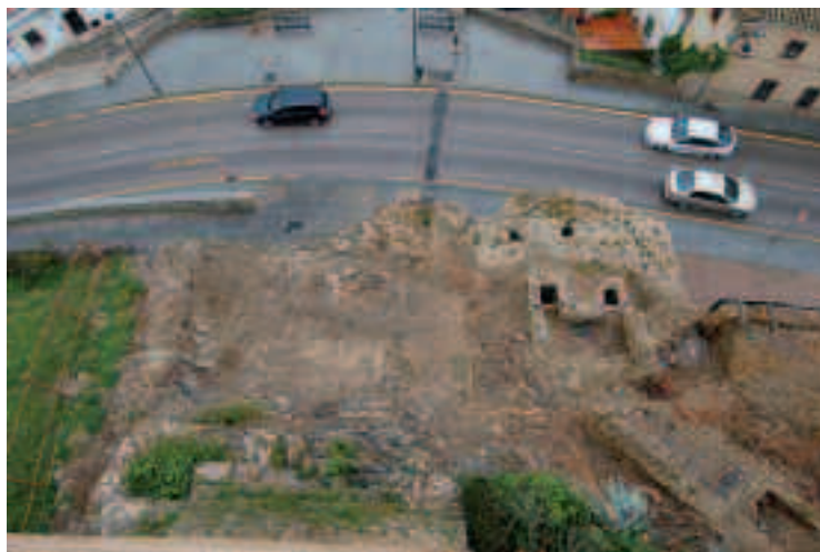
Detalle estructuras excavadas y puestas en valor en Miralrío.
