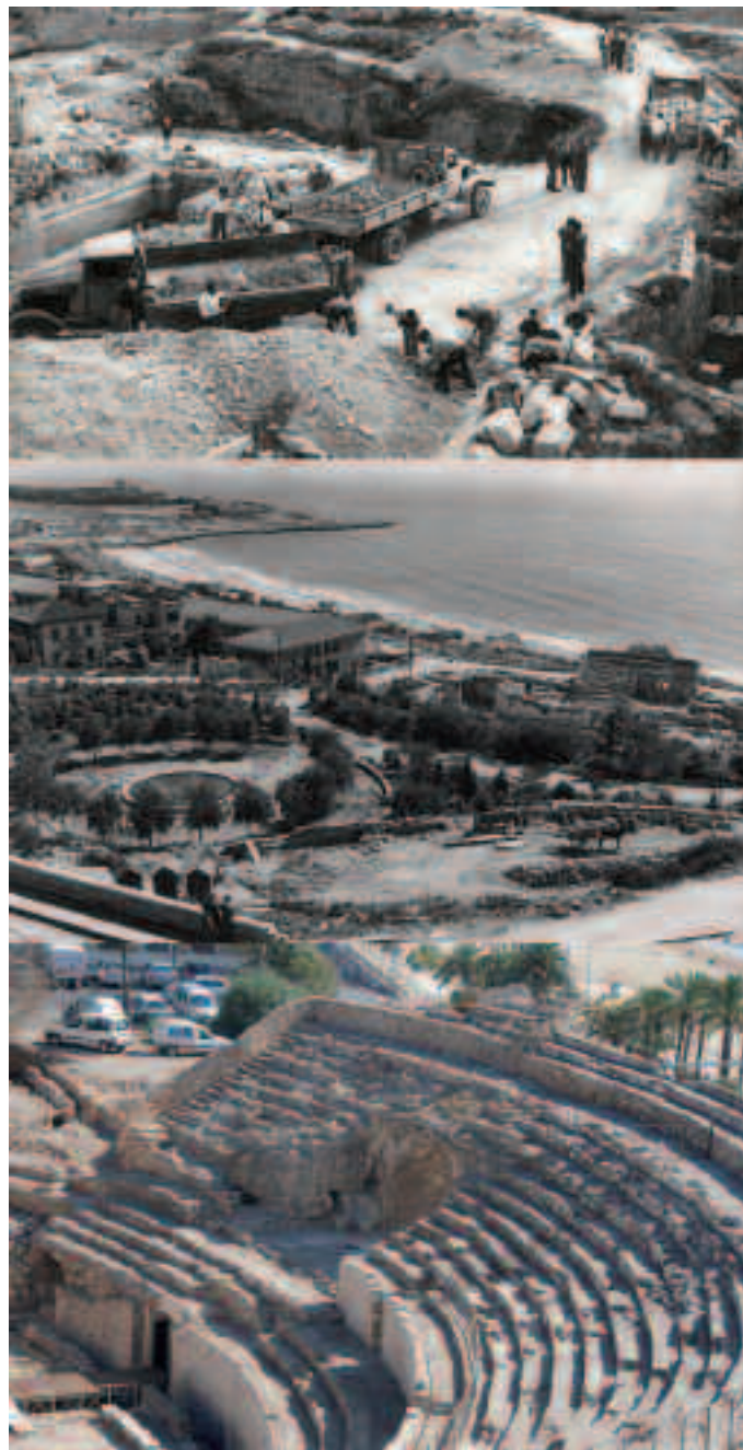
Trabajos de excavación de los Amigos del Anfiteatro (BHPT), obras de adecuación de los jardines y entorno del Anfiteatro (BHPT) y vista de la restauración de las gradas del Anfiteatro, junto a la parte original (X. Tolosana-Museu d'Història de Tarragona MHT).
